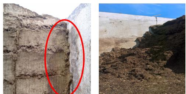
Последствия закладки траншеи без боковой плёнки
